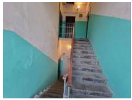
3.stāva kāpņu telpa
